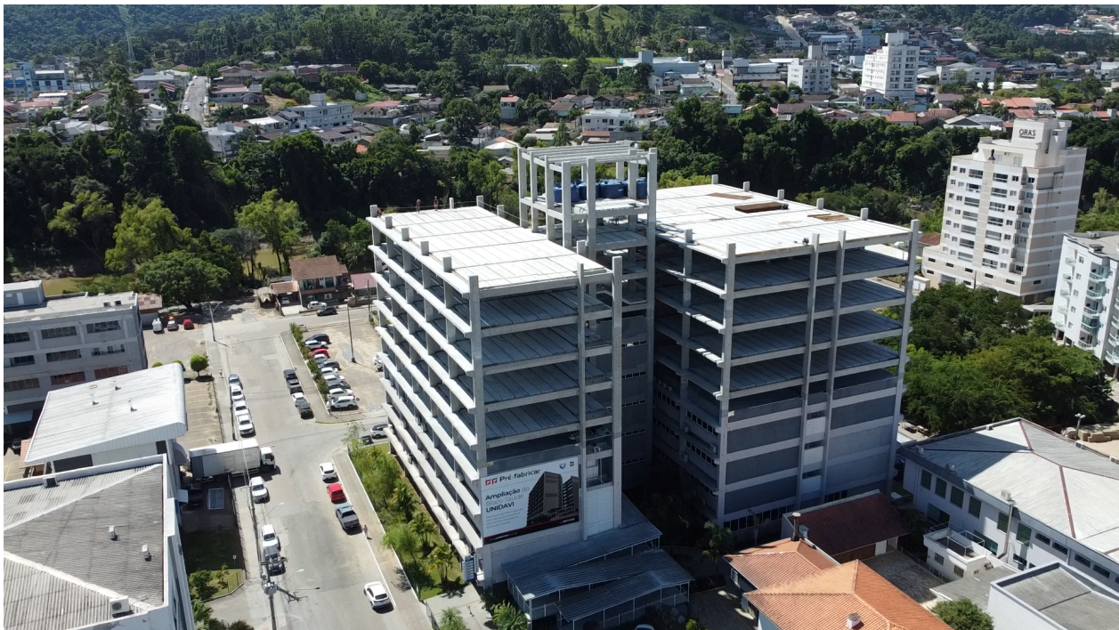
Imagem 38 - Obra de ampliação bloco saúde
