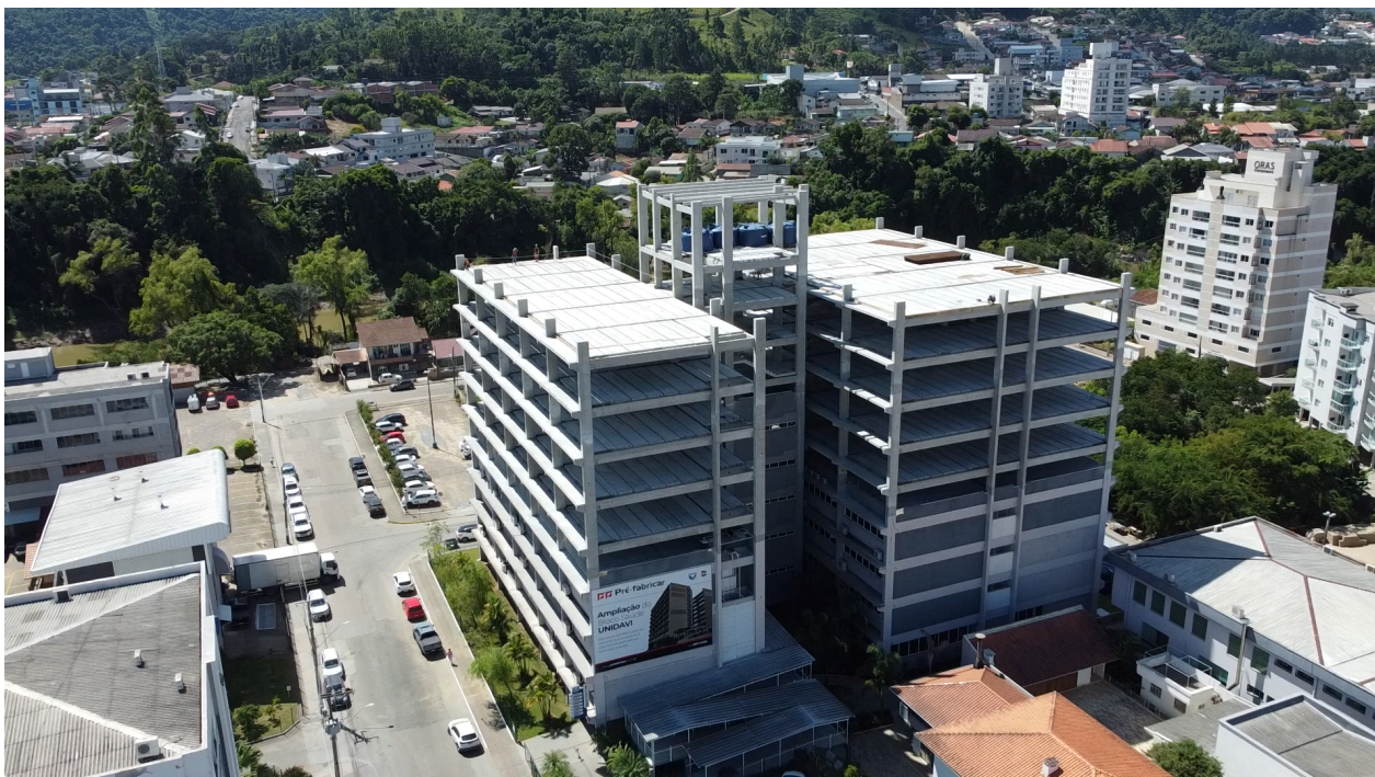
Imagem 37 - Obra de ampliação bloco saúde
